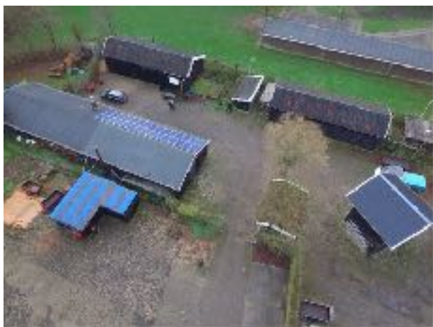
Een deel van het huidige terrein met de timmerwerkplaats, kantoor, metaalwerkplaats, kantine, houtzagerij en houtkloof terrein, hooimijt, opslagplaatsen rijdend materieel en droogplaatsen voor hout
