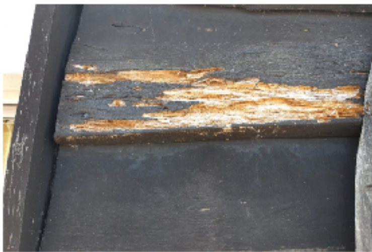
De geïmpregneerde schaaldelen gaan erop: exit boktor
