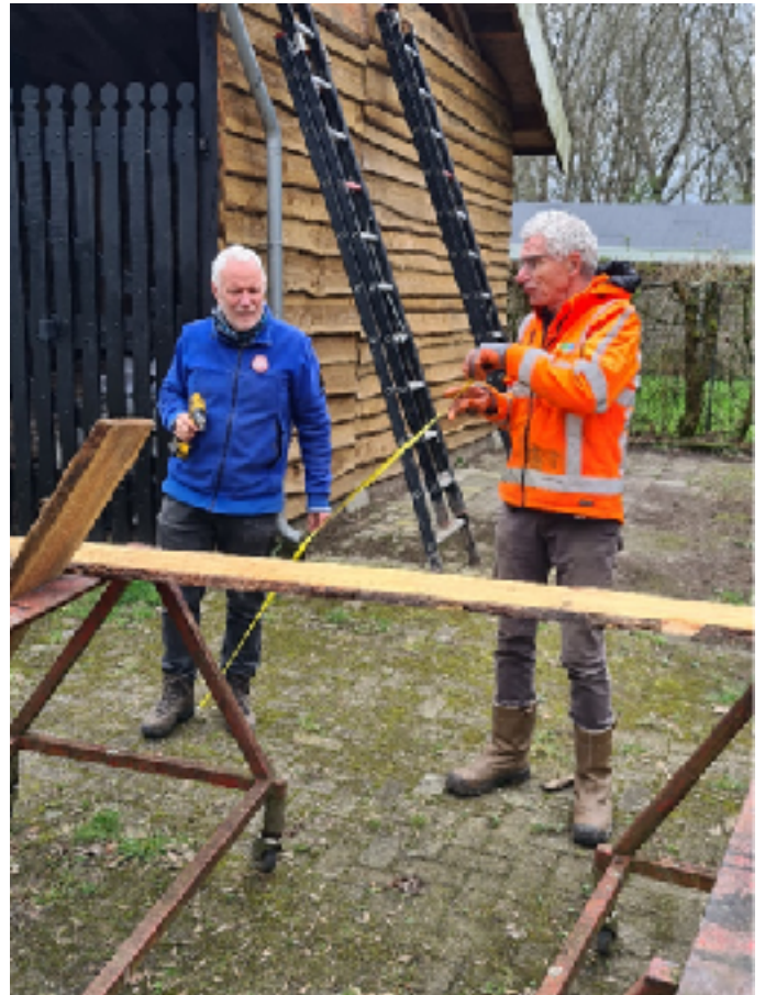
Henk Visser en Rik Wouters (penningmeester VLB) aan de slag om de laatste schaaldelen te vervangen die door boktor waren aangetast.
