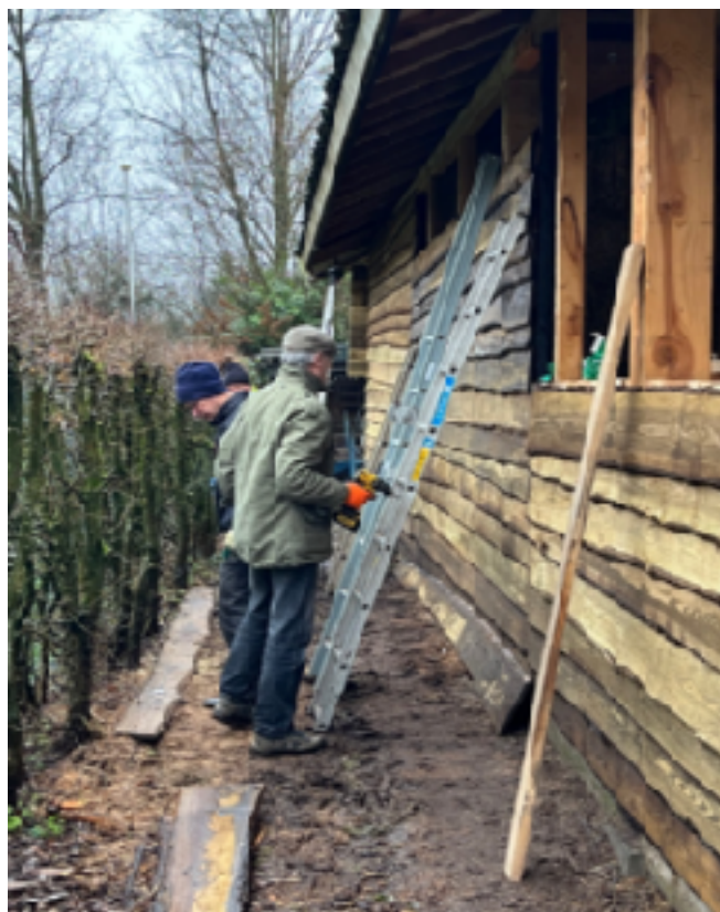
De geïmpregneerde schaaldelen gaan erop: exit boktor
